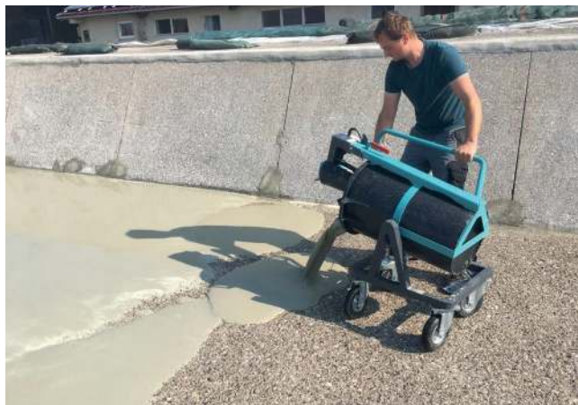
Accessoire spécial : roues pneumatiques pour les surfaces inégales ou pour traverser les tuyaux d'un chauffage au sol.
