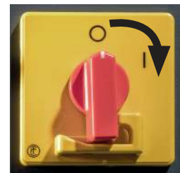
Einschalten des Hauptschalters
